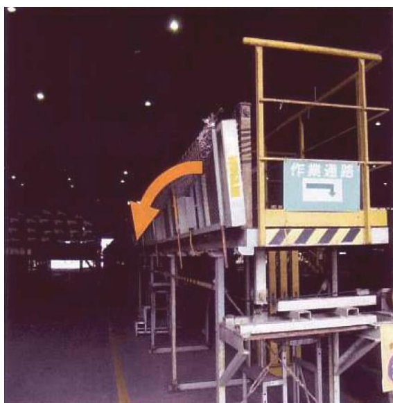
作業床を使用する前
