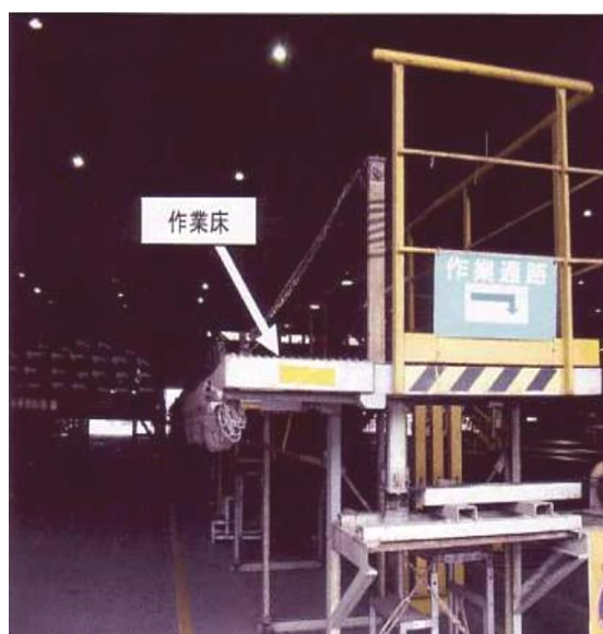
作業床を使用
