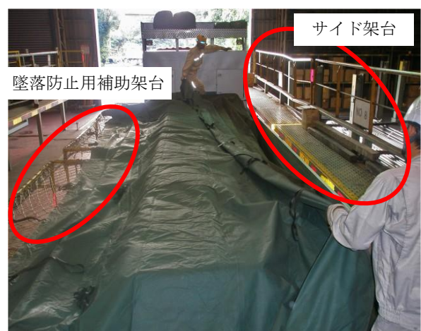
シート掛け作業風景
