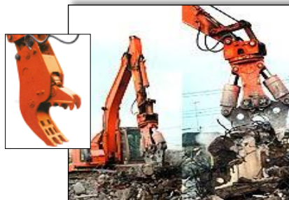
日立建機株式会社製、同社提供 (上写真右はコンクリート圧砕機(大割)・左は同(小割))
