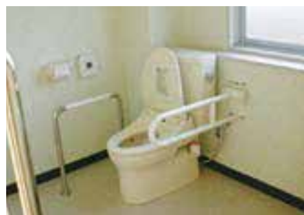
事例2：車椅子用トイレ
